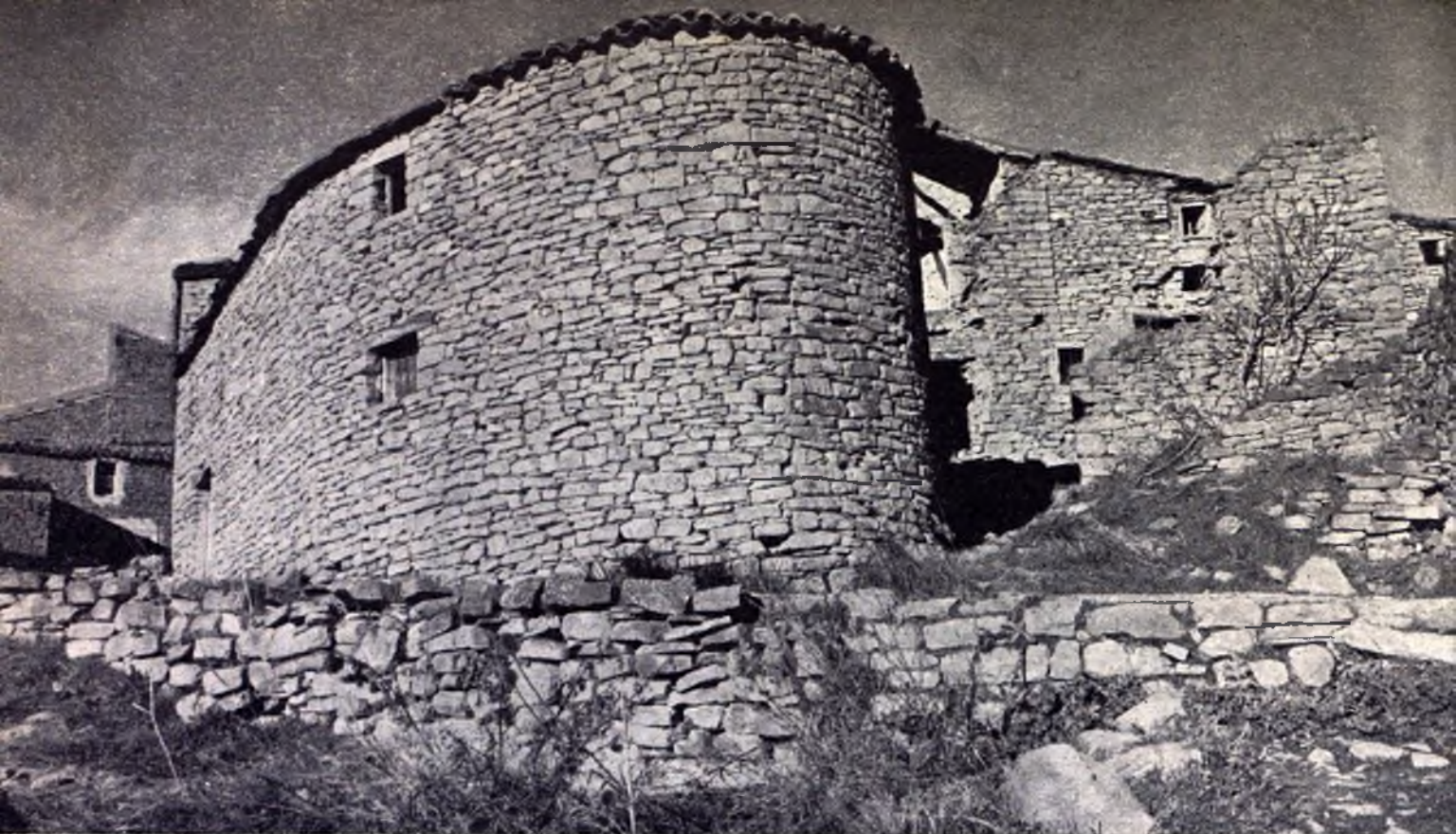
FIG. 68.—Construcción en piedra seca. Amunarrizqueta (Valle de Orba).
