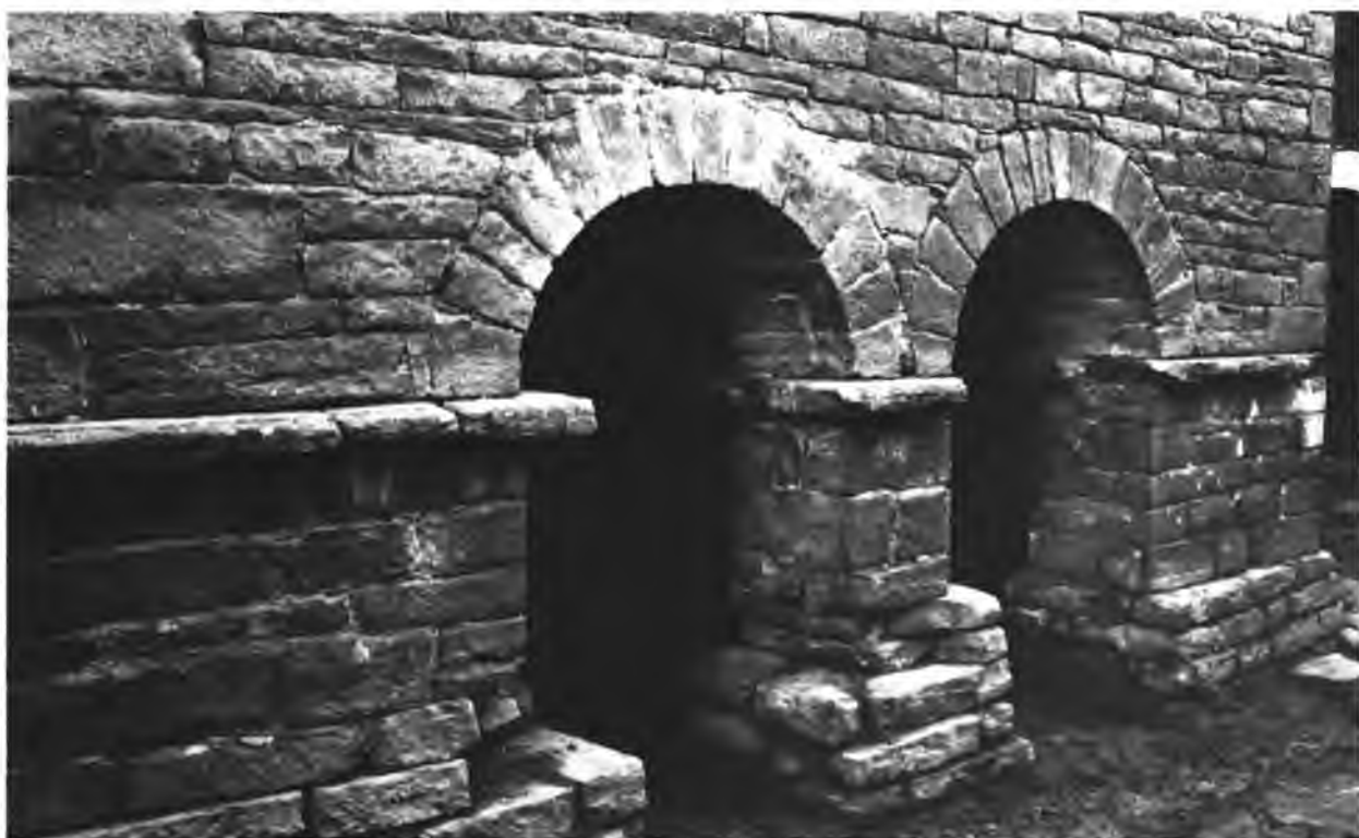
Fig. 25.—Arcos del “hórreo” de Iracheta, restaurados.
