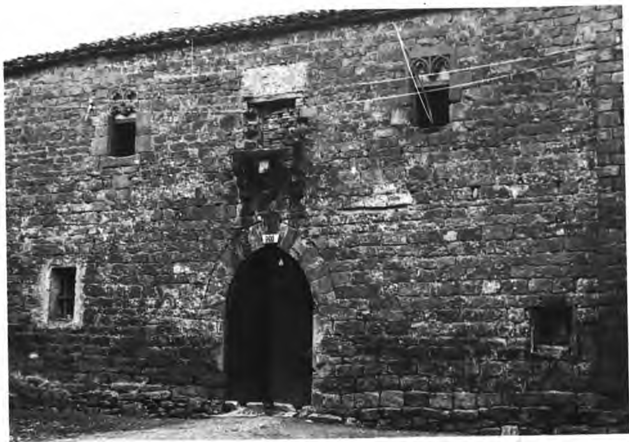
Fig. 46.—Casa gótica, desaparecida. Burlada.
