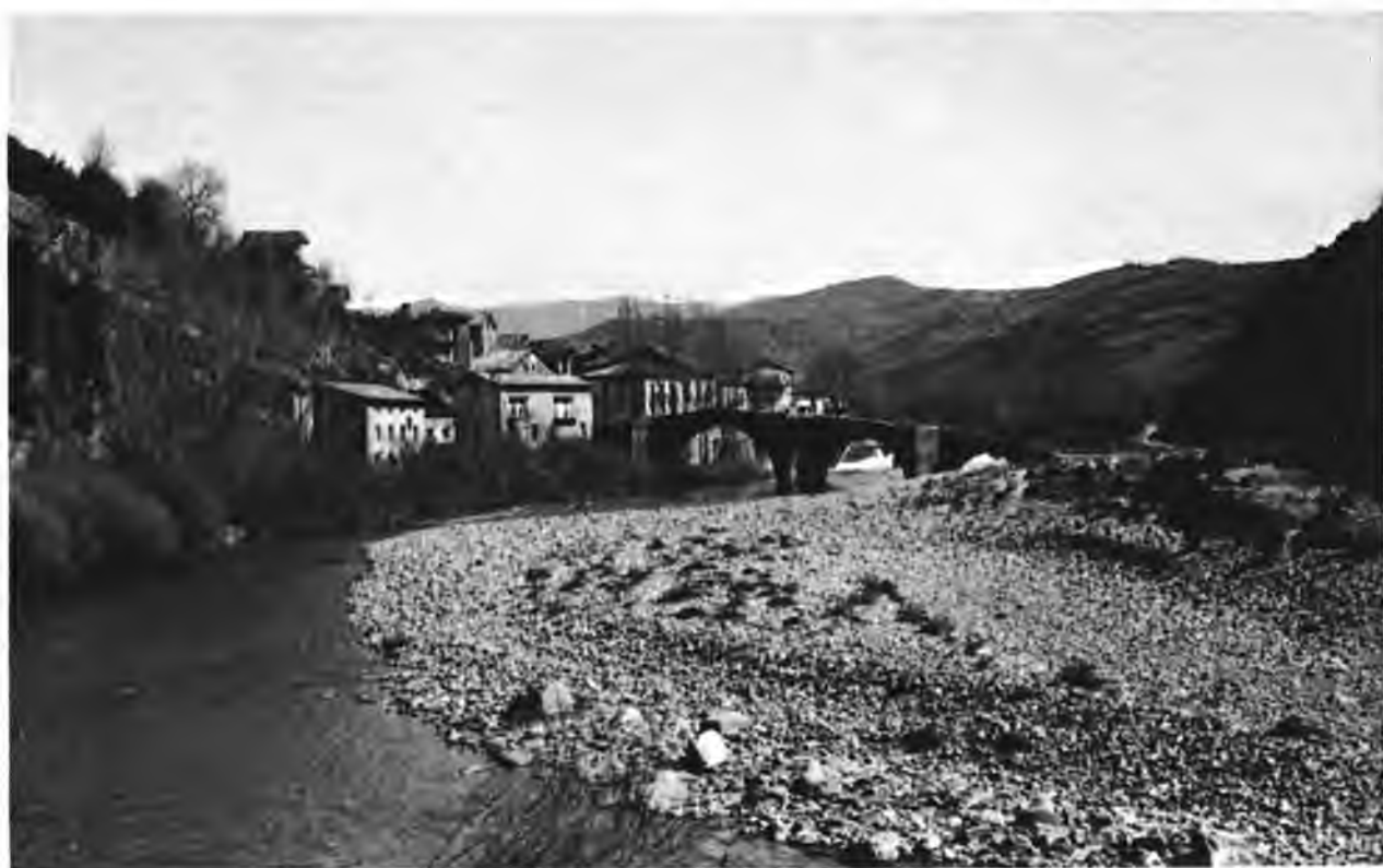
Fig. 293.—El puente sobre el Esca. Burgui.
