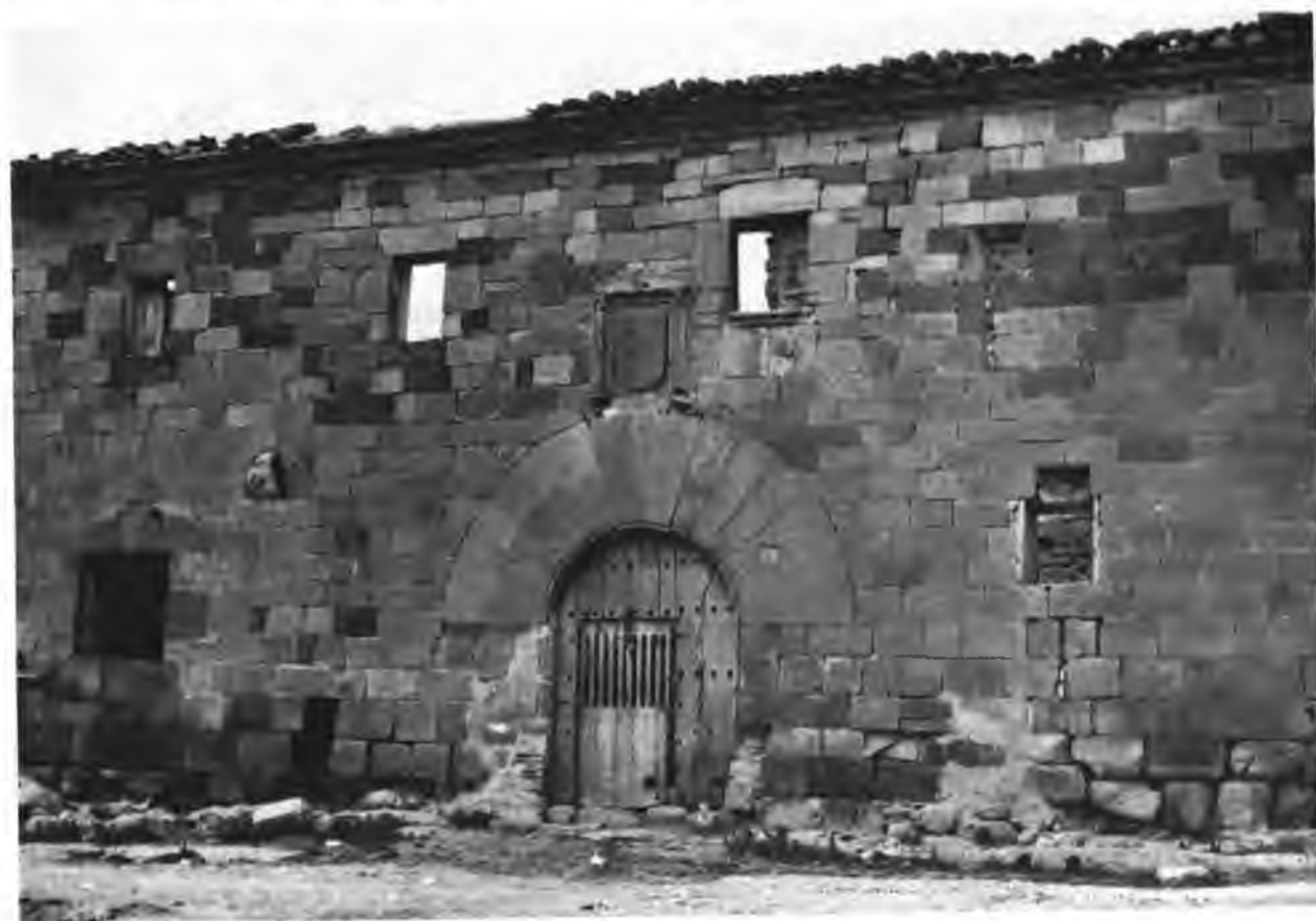
Fig. 531.—Fachada de casa derrumbada, Oco.
