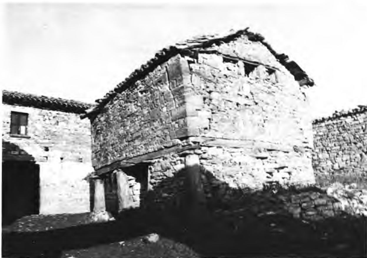
Fig. 188.—Otra vista del hórreo. Antes de la reparación.
