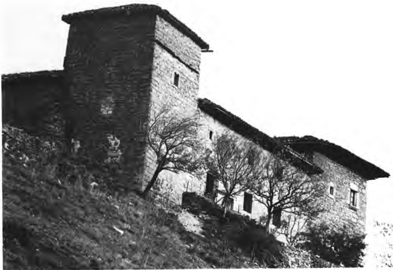
Fig. 97.—Casa torreada de Zalba.
