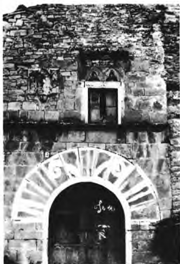
Fig. 484.—Ventana con blasón y tallas. Arizaleta.
