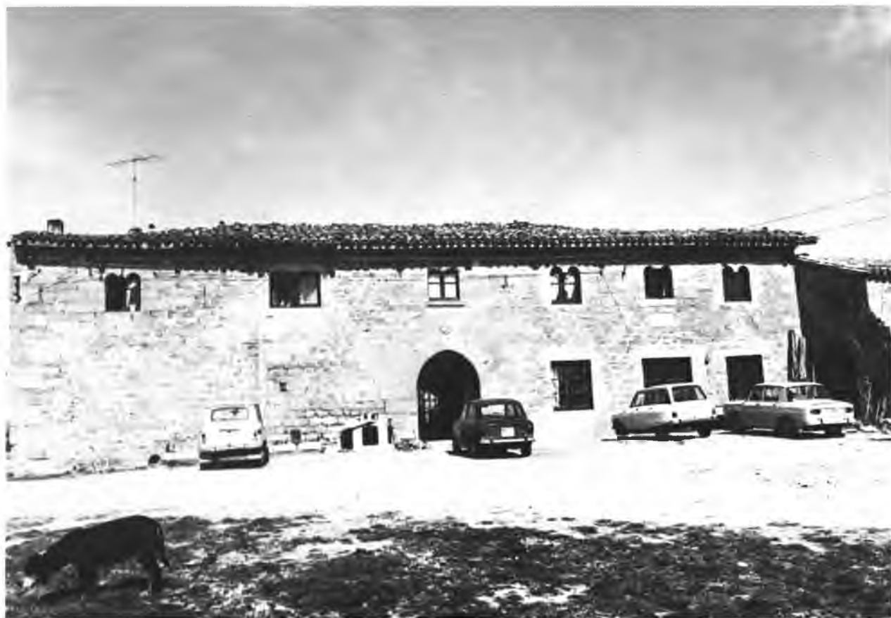
Fig. 168.—Casa de la figura anterior. después de la restauración.
