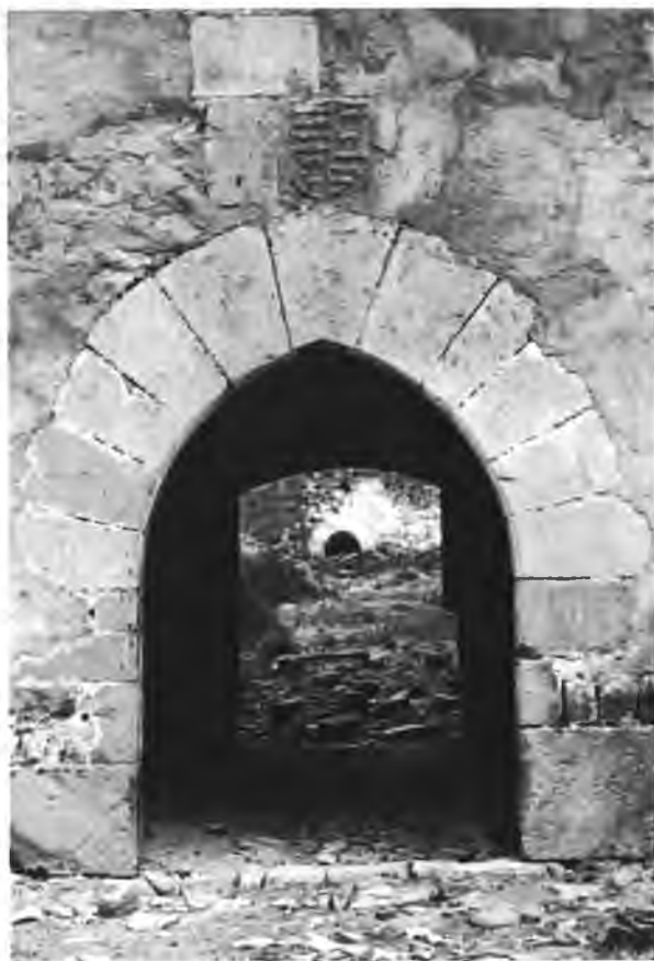
Fig. 161.—Puerta de la torre de Ezgay.
