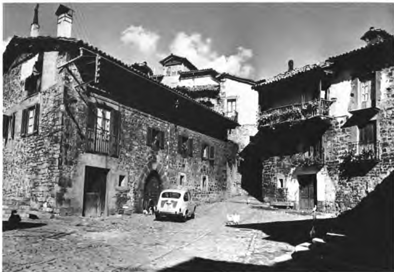
Fig. 305.—Plazuela de Roncal, reformada.
