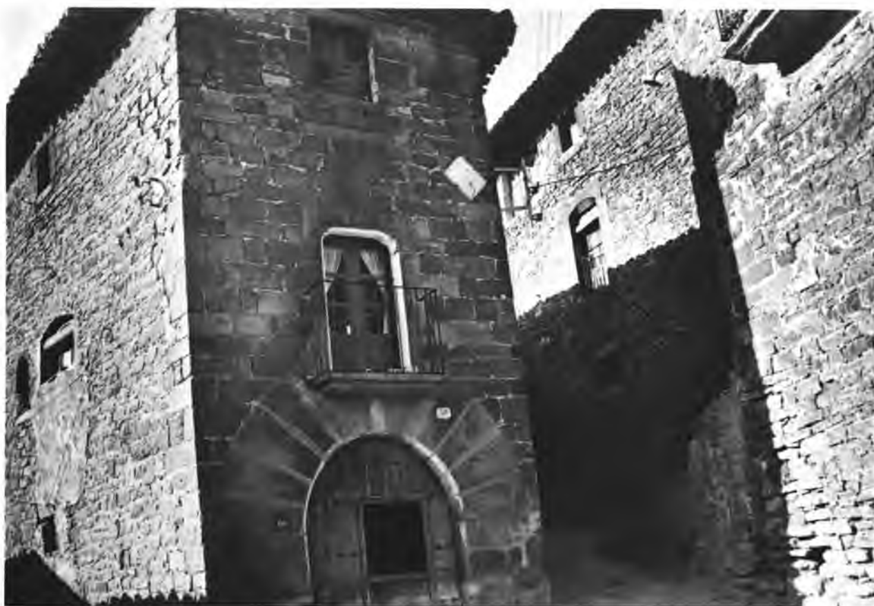
Fig. 247.—Casa reformada. Aibar.
