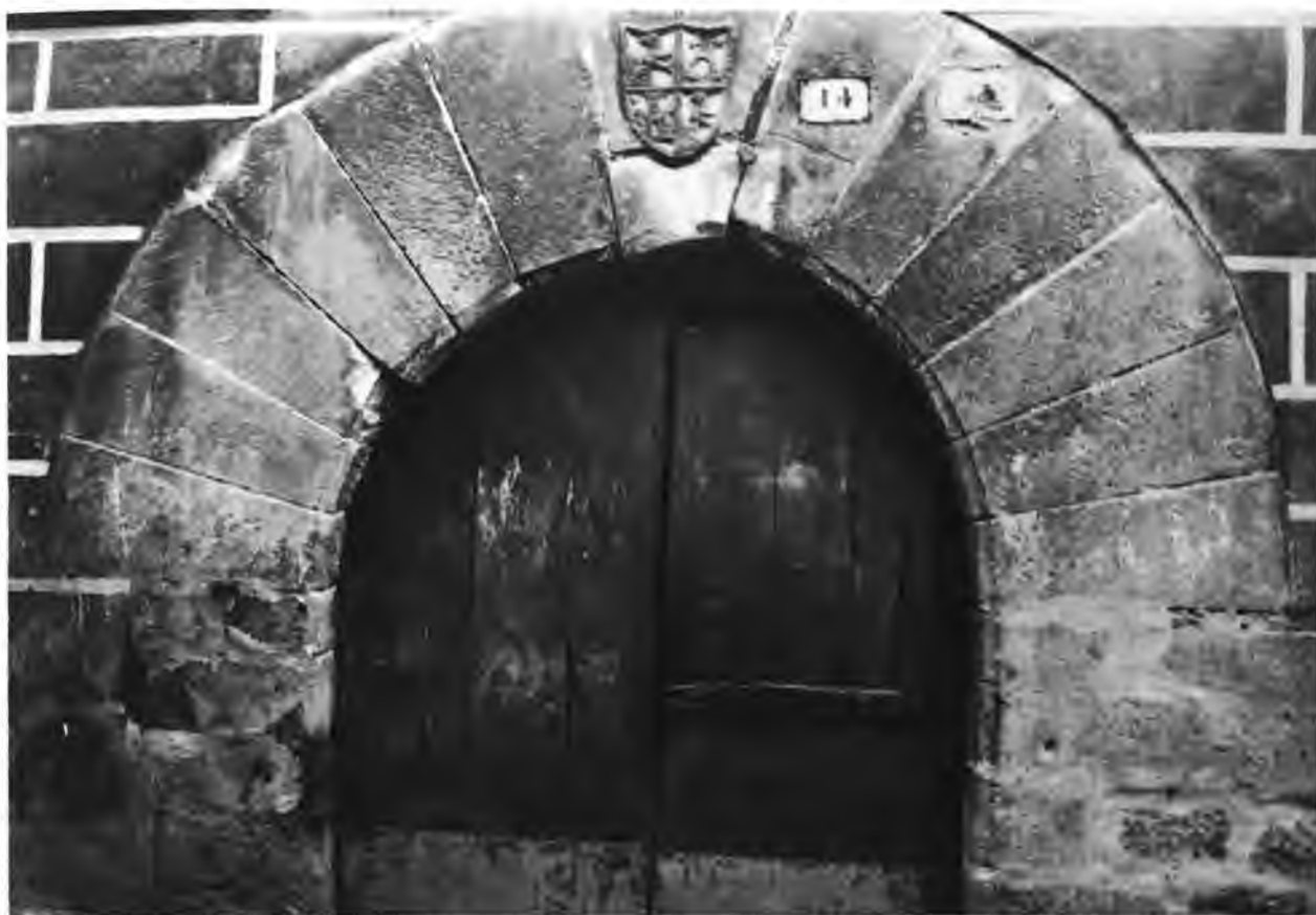
Fig. 249.-Arco blasonado. Aibar.
