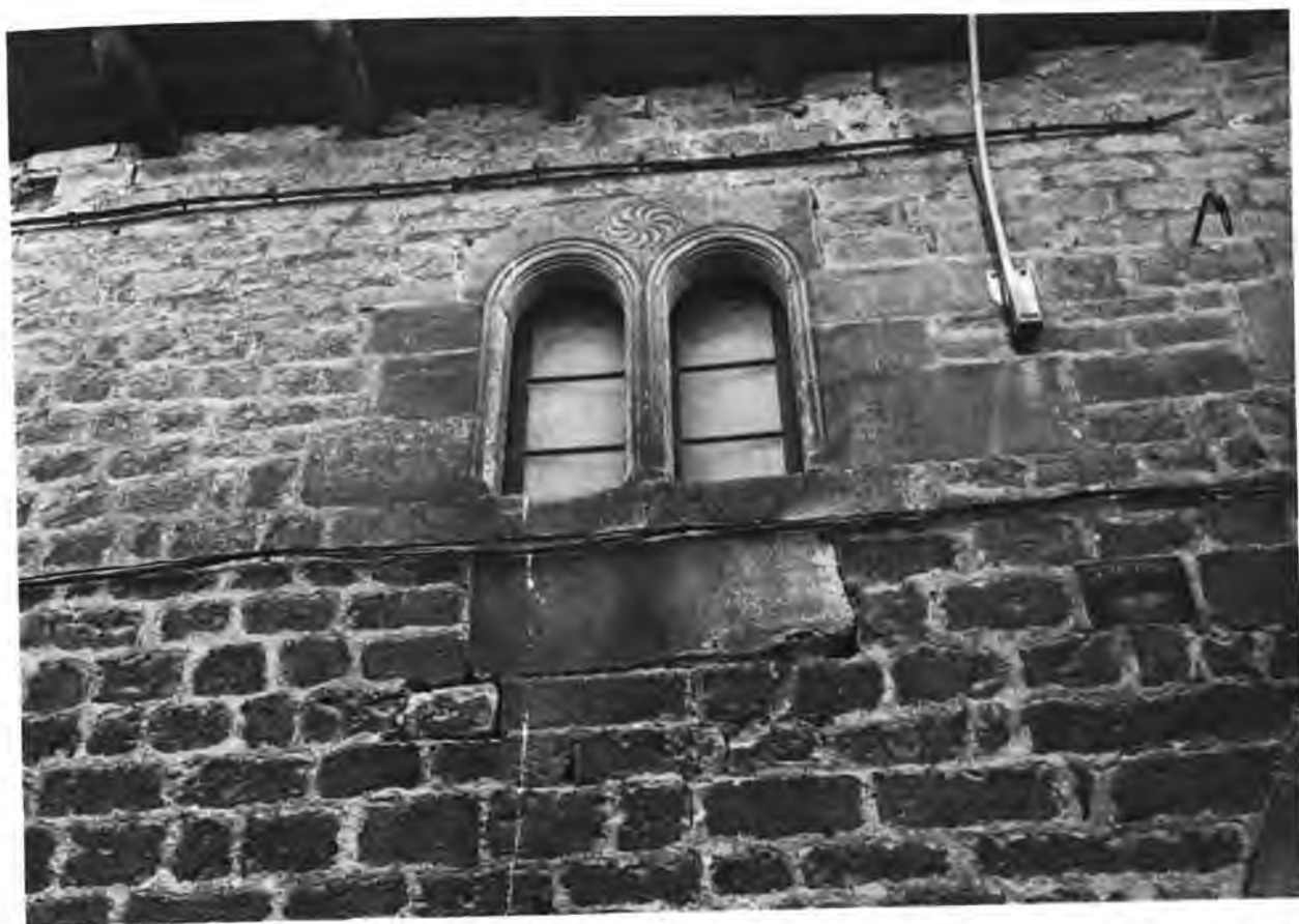
Fig. 87.—Ventanal de la casa de D. a Blanca. Urroz.
