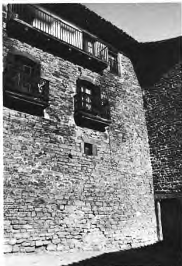
Fig. 251.—Casa reformada. Aibar.
