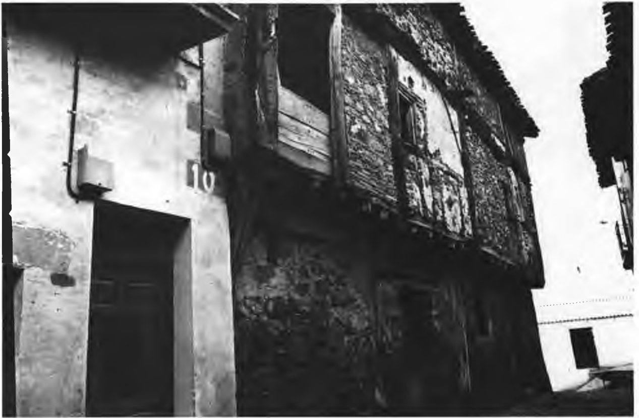
Fig. 572.—Casa con voladizo. Genevilla.
