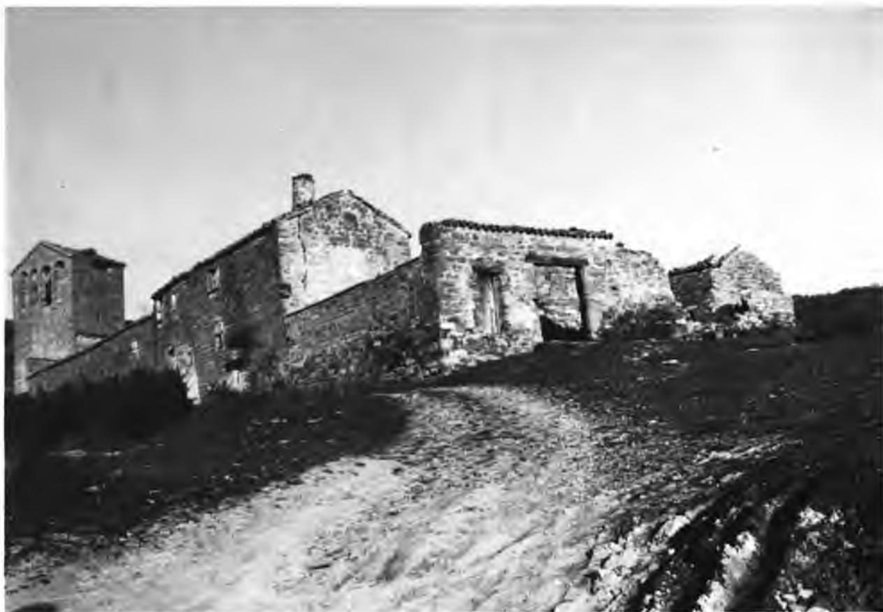
Fig. 185.—Santa Fe de Eparoz. Entrada principal, antes de la reparación.
