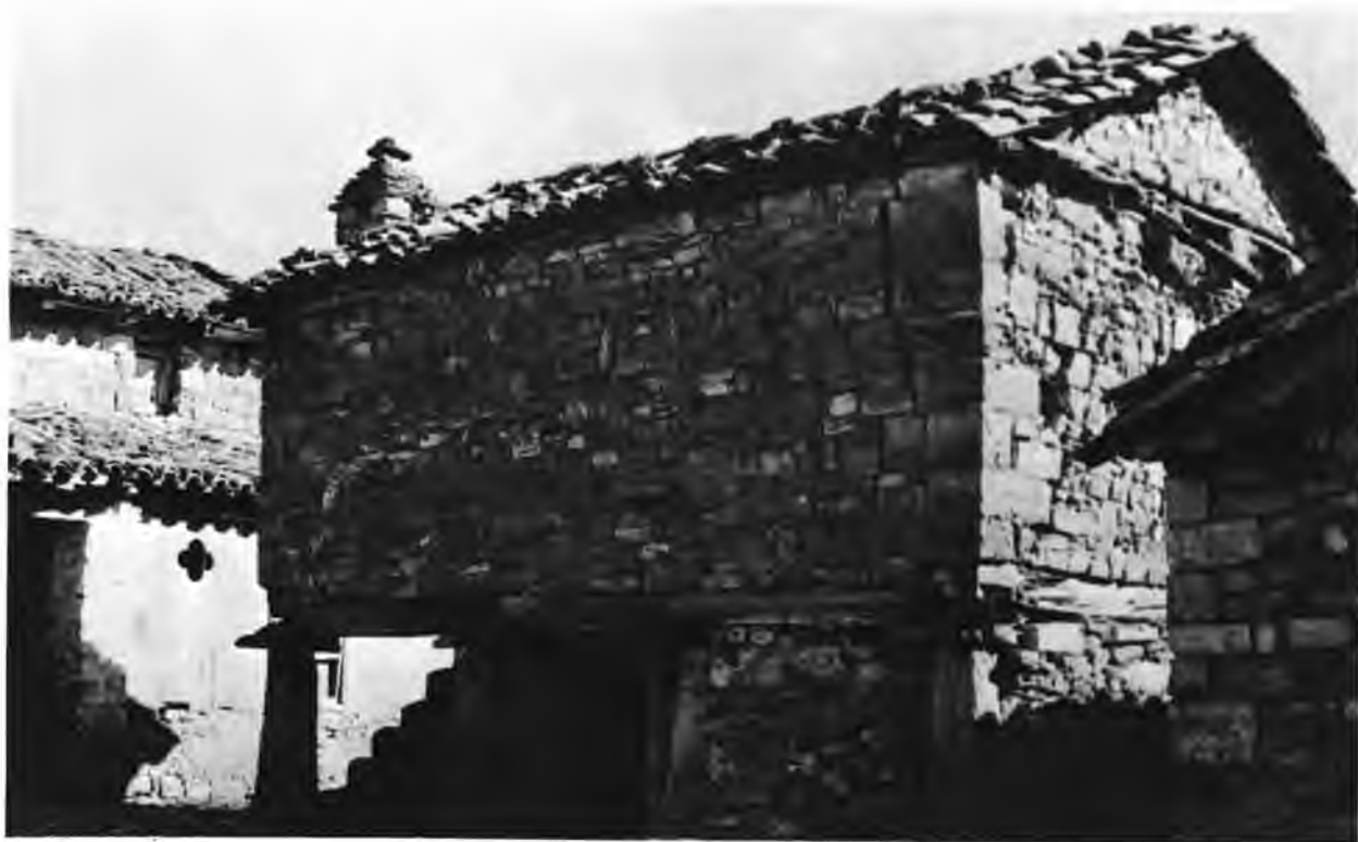
Fig. 187.—Hórreo de Santa Fe de Eparoz. Antes de la reparación.
