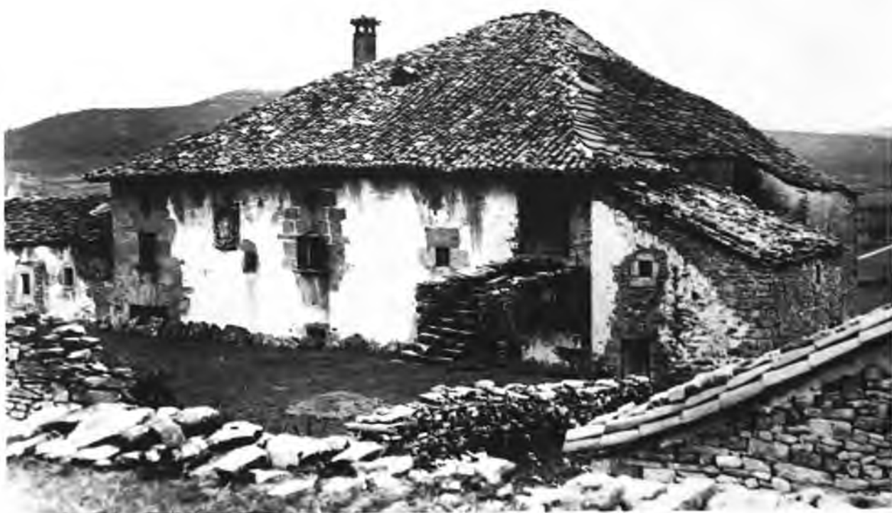
Fig. 419.—Casa con lajas de piedra en el tejado. Azanza.
